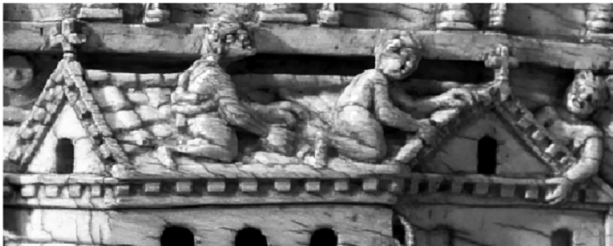
Fig. 6. Homilías de San Gregorio Nacianceno, fol. 316r: detalle de unos operarios reparando el tejado (supra); marfil de Tréveris, detalle del tejado de la basílica (infra).
