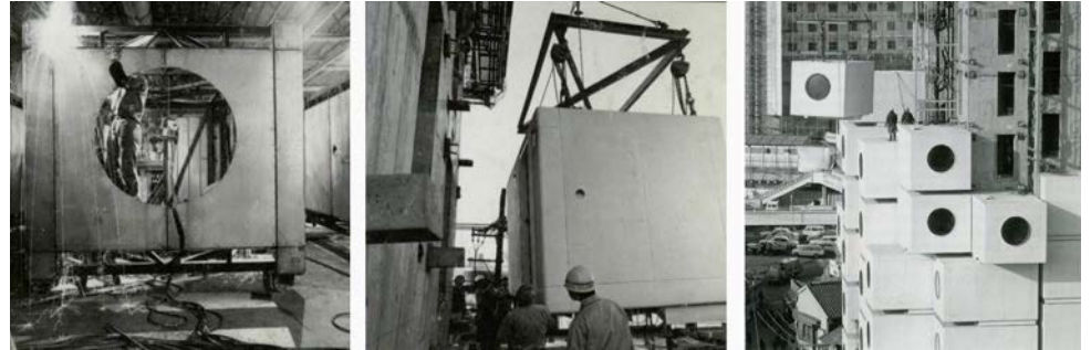
Imagen 16. Fabricación y montaje de una cápsula tipo
