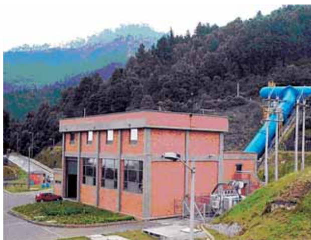
Foto 1. Central Hidroeléctrica Santa Ana.
