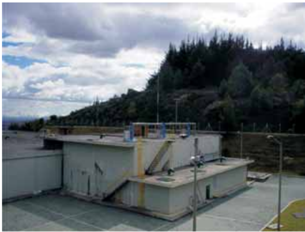
Foto 2. Tanque Santa Ana.
