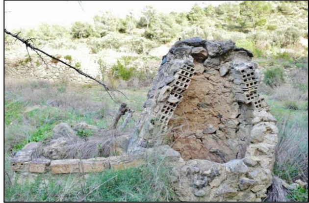
Imagen 3. Cabezal de un aljibe junto a un pilón de piedra en el paraje del Madroñal.
