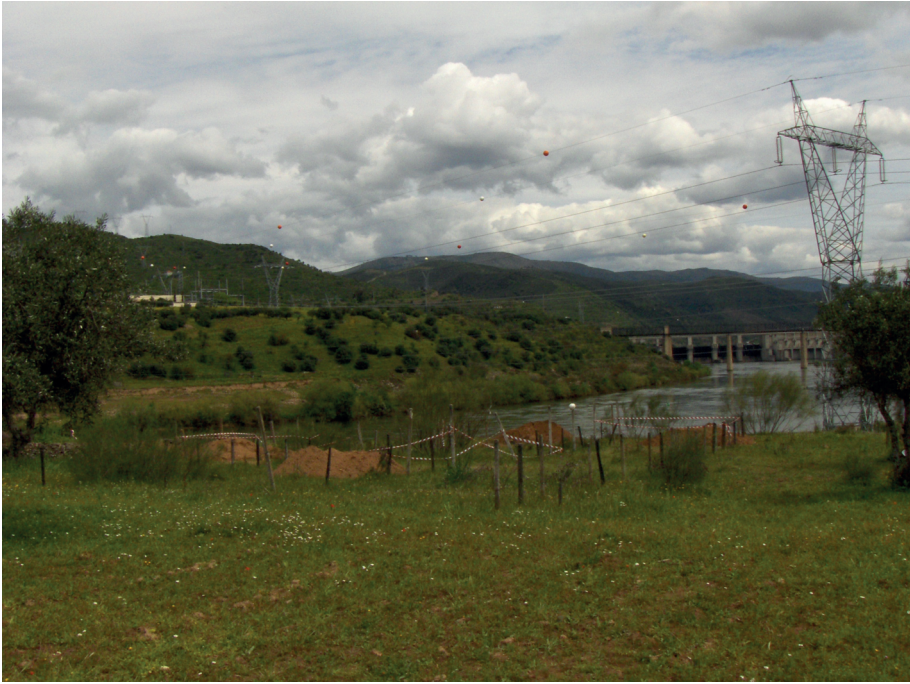
Fig. 4: Vista geral da área intervencionada.
