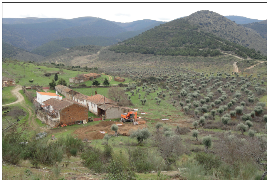
Fig. 2. Início dos trabalhos na Quinta de Crestelos em fevereiro de 2012.
