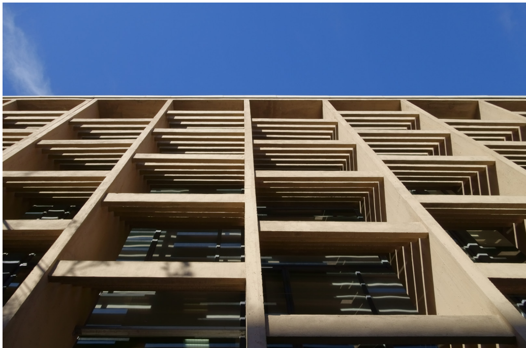
5. Parasoles horizontales fijos en la fachada lateral de la Facultad de Filosofía y Ciencias de la Educación, en la calle Dr. Rodríguez Fornos (Fotografía del autor, 2018)
