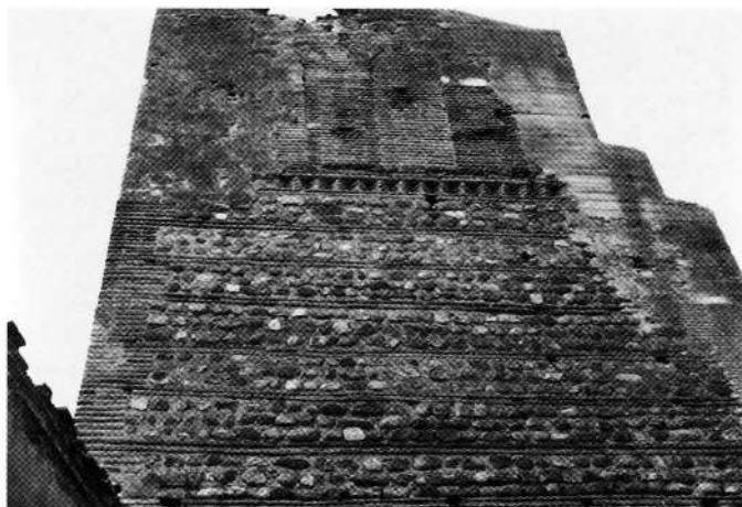
Foto núm. 42: Torre desde el lado este.
