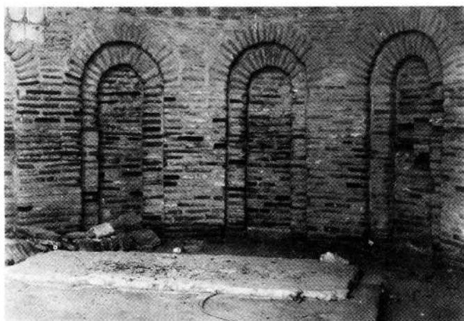
Foto núm. 37: Detalle de las arquerías inferiores del ábside central.
