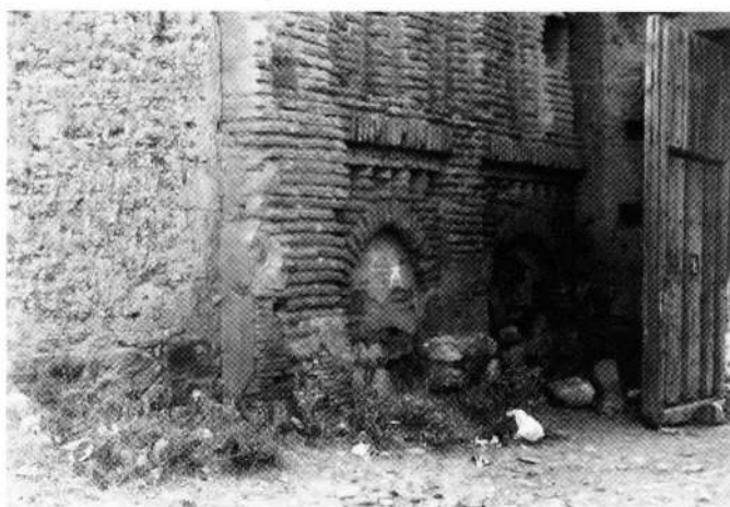
Foto núm. 50: Belver de los Montes: Arquerías exteriores hacia los pies.
