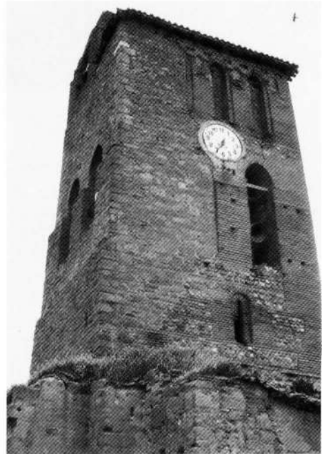
Foto núm. 46: Detalle de la torre desde el lado sur.
