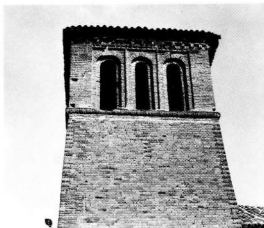
Foto núm. 54: Detalle de la torre anterior.
