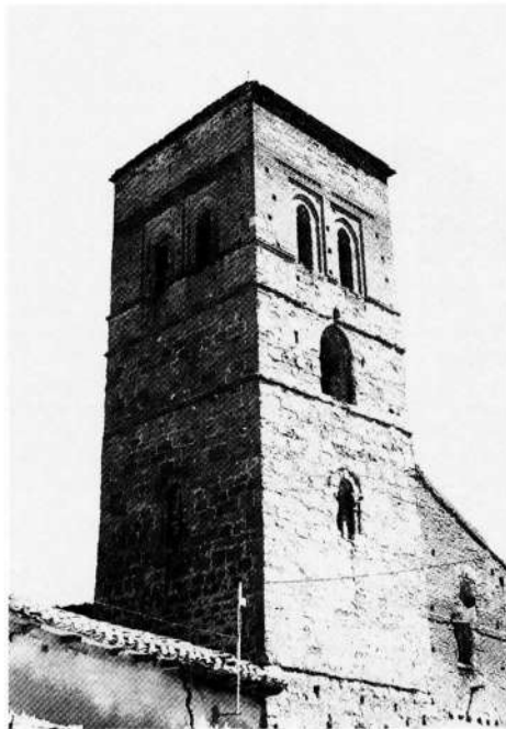
Foto núm. 52: vista desde el noroeste.
