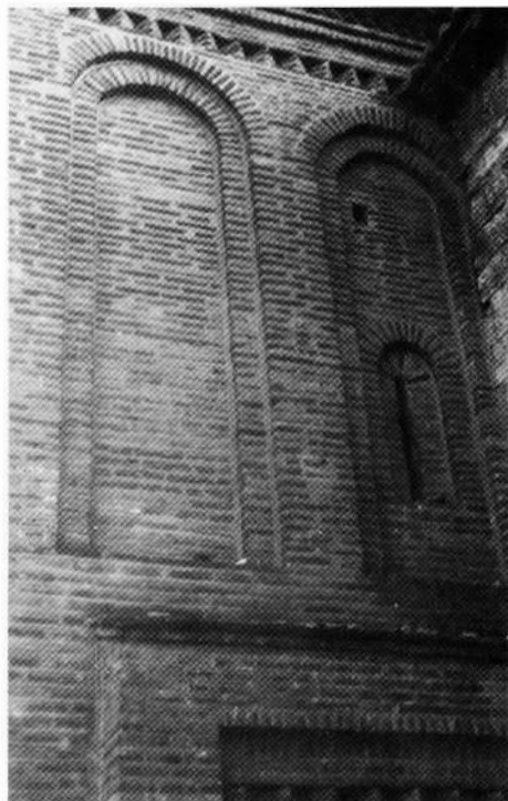
Foto núm. 5: arquerías del muro norte.
