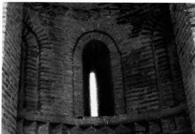
Foto núm. 40: Detalle del ábside del evangelio.
