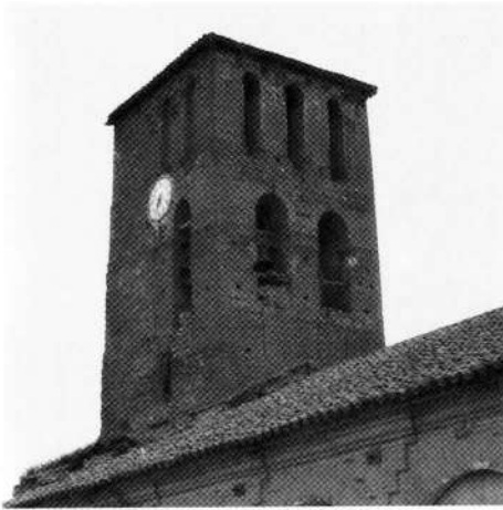
Foto núm. 45: Torre desde el ángulo sureste.
