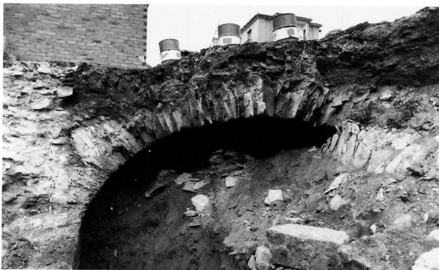
Corte Oeste de la Nave subterránea a nuestra llegada al solar.
