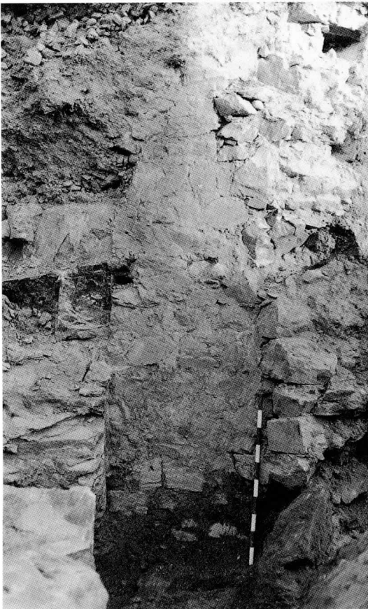
Muro de la boca de carga.
