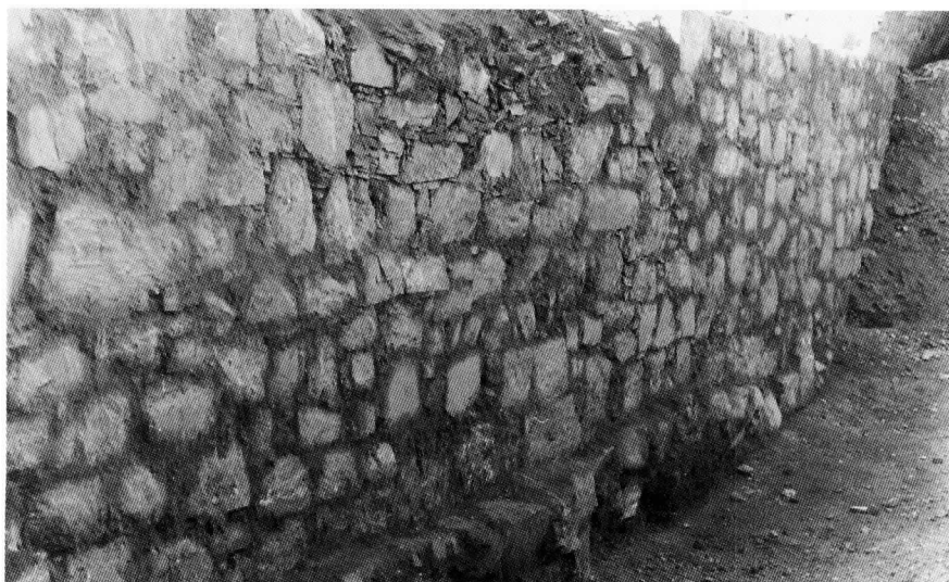
Muro Sur de la bodega.
