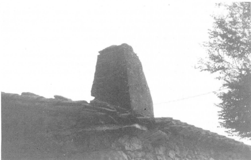
FOTO 29. Chimenea troncocónica (exterior)
