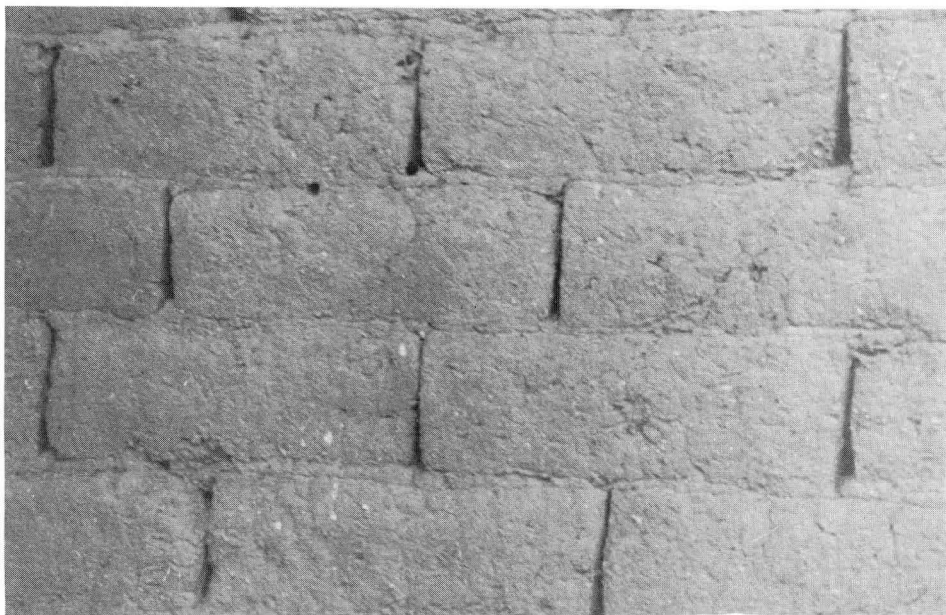
FOTO 3. Pared fabricada con adobe
