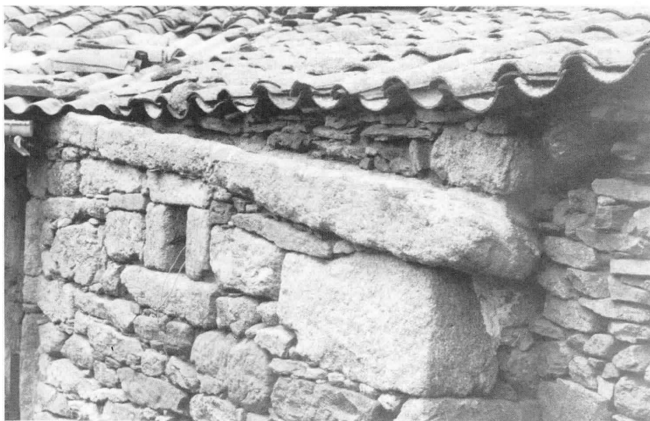
FOTO 36. Canalón tallado en piedra
