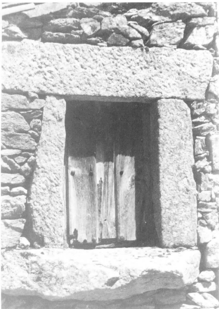
FOTO 25. Arquitectura Rural sayaguesa. Ventana
