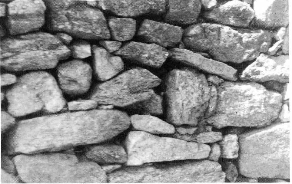
FOTO 4. Pared de mampostería de granito
