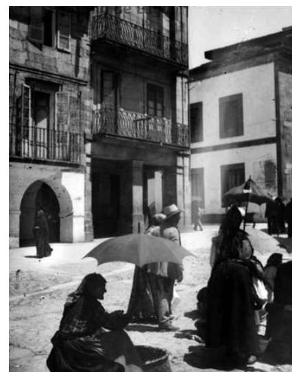
Fig. 8. Vista da esquina do Méndez Núñez do lado da praza Maior, ca. 1900, co edificio n.º 2 sen reformar aínda (AMLu, sig. 1211, fot. Salvador Castro Freire).
