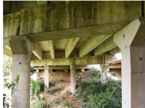
Figura 4. Puente sobre afluente Cauto. Autopista Nacional de Santiago de Cuba. Cuba. a) Losas y vigas prefabricadas de hormigón sobre cabezales del mismo material. b) Subestructura prefabricada de hormigón armado.
