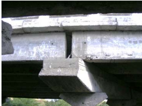
Figura 4. Puente sobre afluente Cauto. Autopista Nacional de Santiago de Cuba. Cuba. a) Losas y vigas prefabricadas de hormigón sobre cabezales del mismo material. b) Subestructura prefabricada de hormigón armado.
