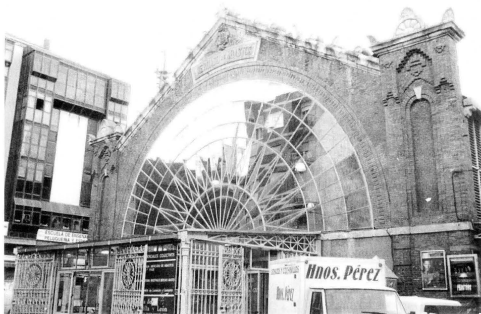
FOTO 5. Fachada septentrional del mercado.
