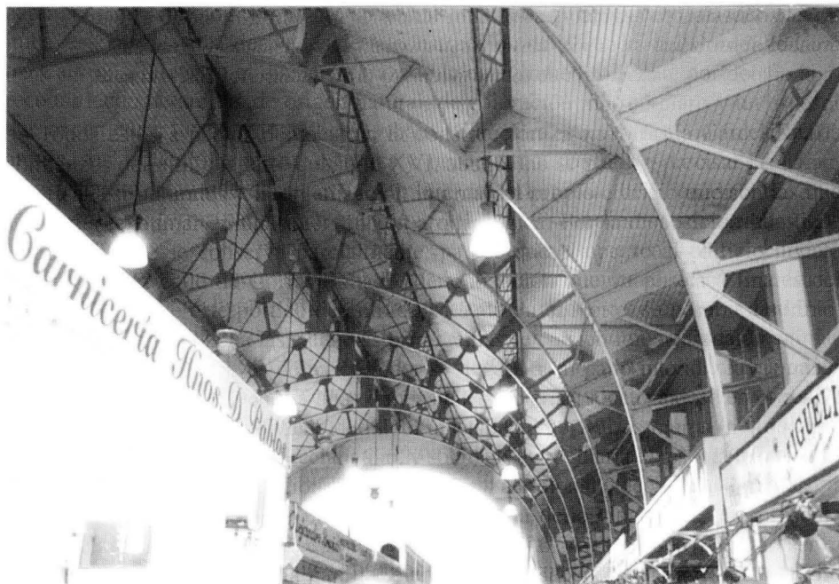
FOTO 6. Armadura férrea del mercado.
