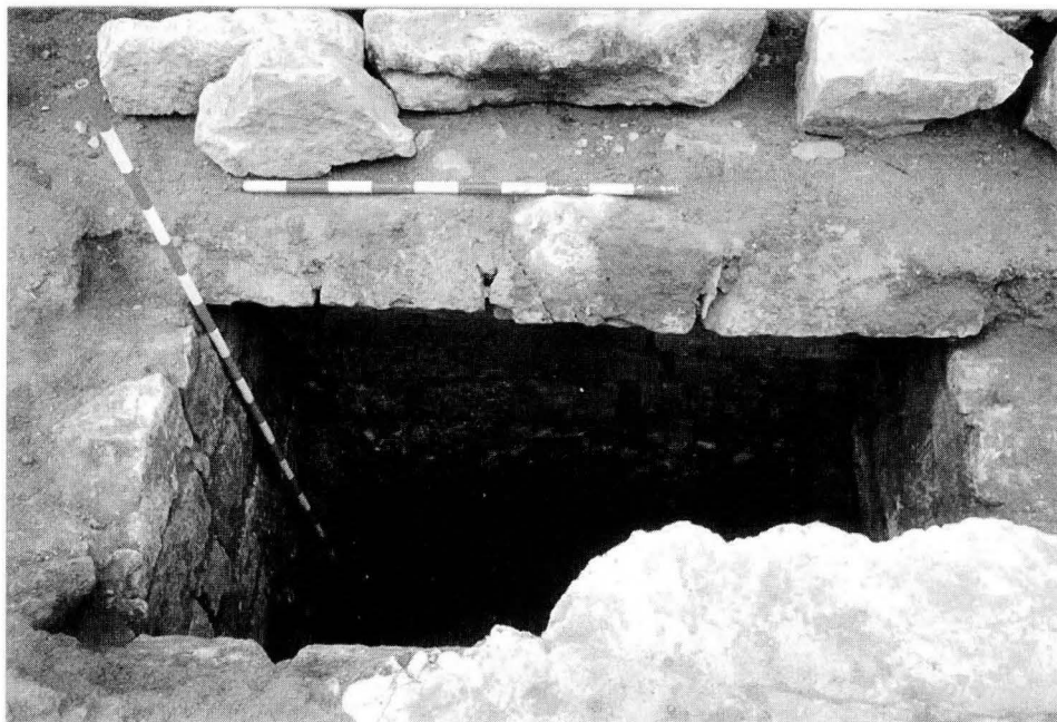
Foto 5. Restos de la cubierta abovedada de la estructura localizada frente al tramo recto Sur de la cabecera.
