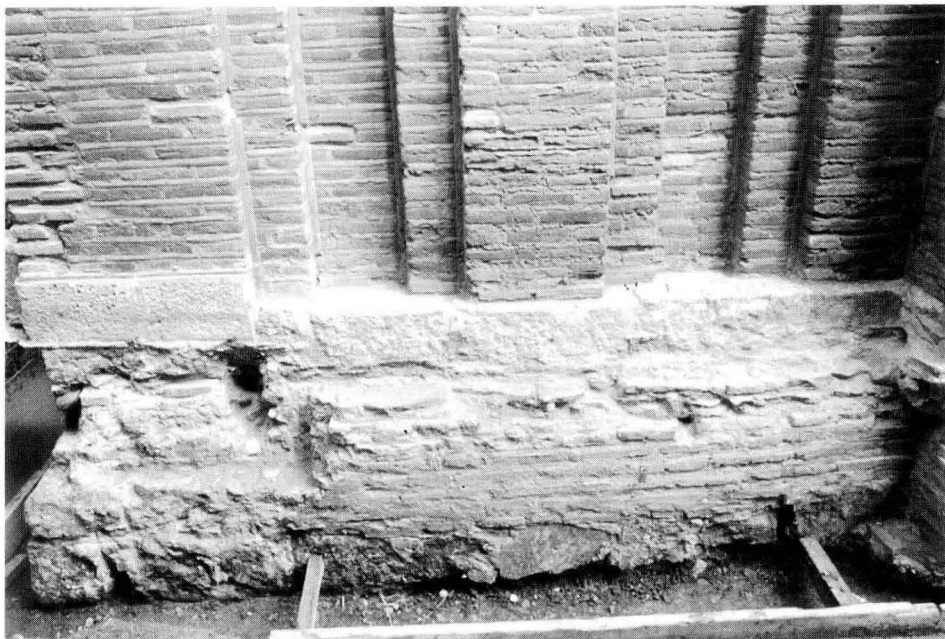
Foto 4. Alzado de ladrillos original del tramo Norte del hastial.
