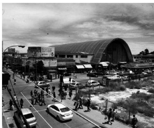
Figura 15 Vista exterior MCC. Fuente: Pastorelli (2013).
