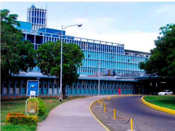
Foto 2. Hospital Universitario de Maracaibo
