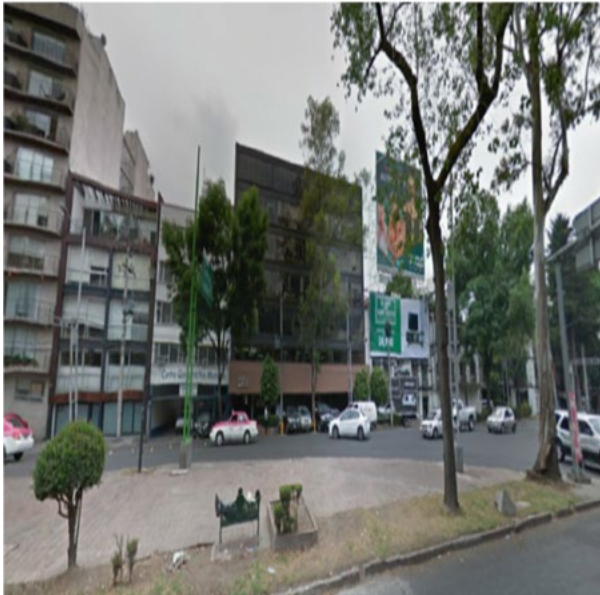
Imagen 2. Edificio en Álvaro Obregón No. 286 antes y después del terremoto
