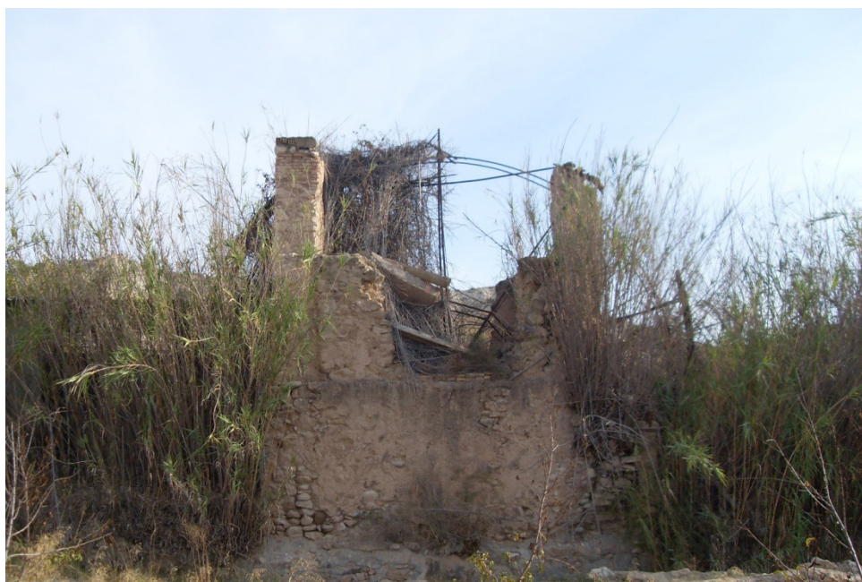
Imagen 2. Restos de una de las norias de funcionaron en la ribera del río Mula para elevar el agua y ampliar el área de regadío en el T. M. de Albudeite
