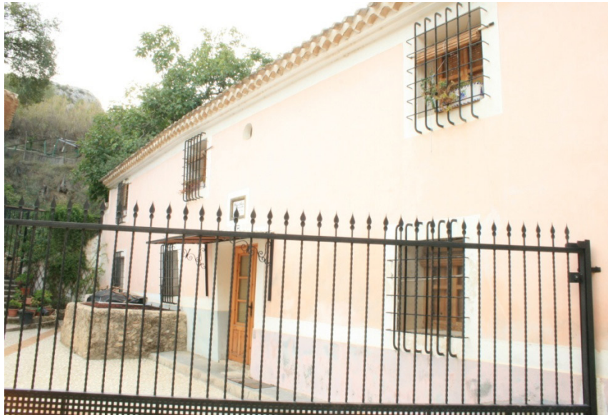
Imagen 3. Fachada rehabilitada del edificio del Molino de Arriba, en término municipal de Bullas
