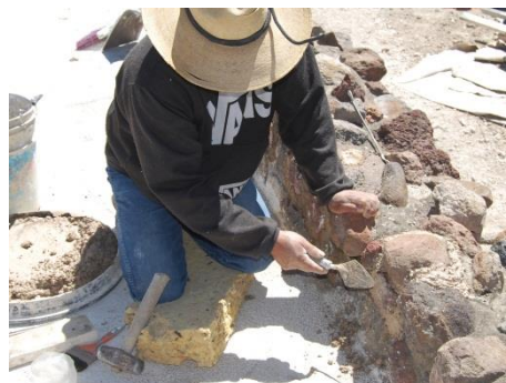
Figura 5: Restitución con tierra estabilizada con cal en restos arqueológicos de muros de piedra. Teotihuacán, México (2016).
