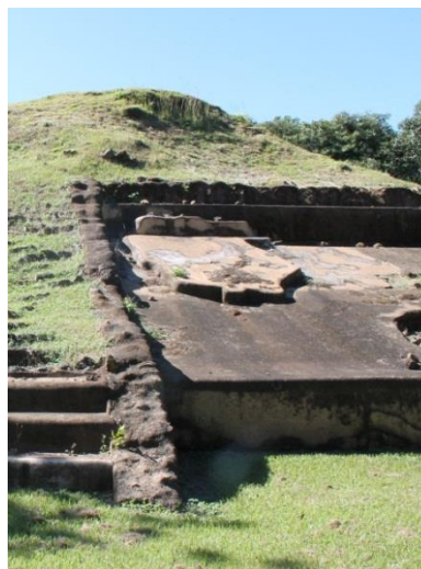
Figura 6: Uso de tierra compactada estabilizada con cal y puzolanas para el llenado de superficies faltantes en las pirámides de Casa Blanca, El Salvador (2014).
