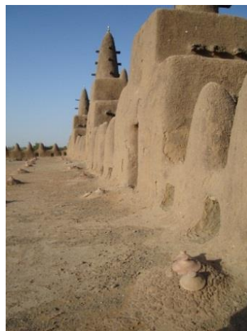
Figura 2: El sistema manual de eliminación de aire caliente del techo de la Mezquita de Djenée, en Mali, contribuye a generar un ambiente confortable en su interior, a pesar del intenso calor del desierto (2008).
