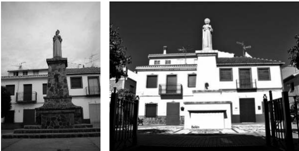
Vista general del monumento 96 y vista actual tras la restauración 97 .
