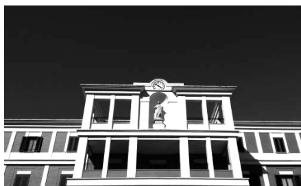
Vista general de la fachada con la imagen 182 . Detalle de la misma 183 .
