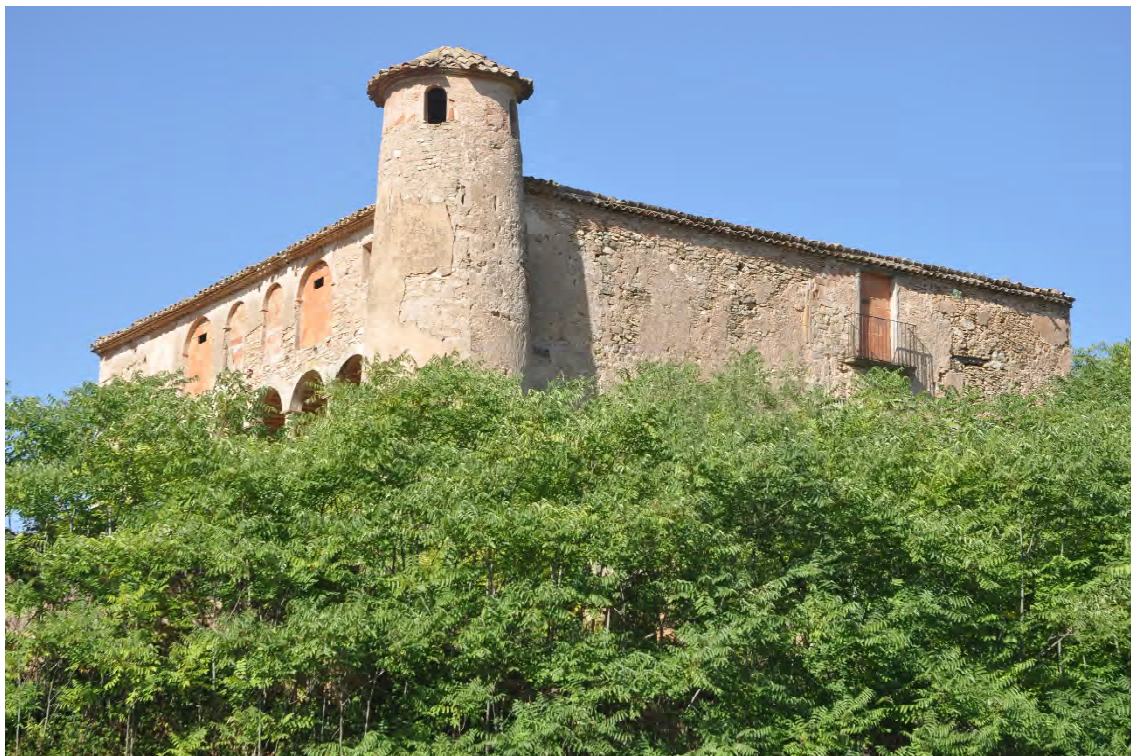
Mas d'en Xup. Torre amb aires de fortificació que flanqueja la cara de llevant (Foto. A. Carreras, 2015).
