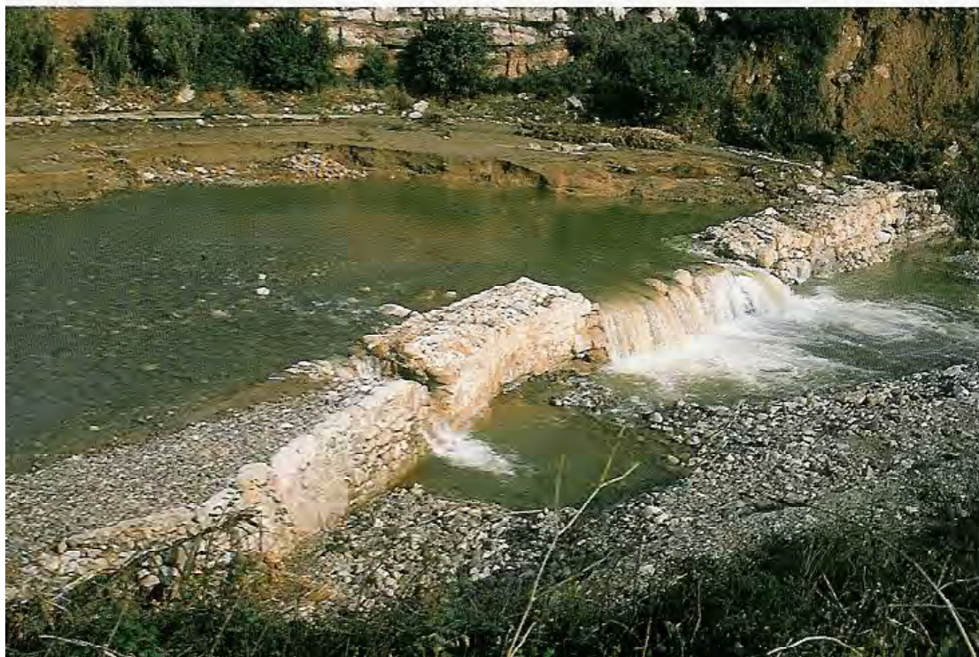
Resclosa. Aquesta resclosa bastida amb calç i pedres al segle XII, proporcionava aigua a la bassa del molí a través d'una sèquia que travessava tota la partida de la Sinoga. (Foto A. Carreras, 1994).
