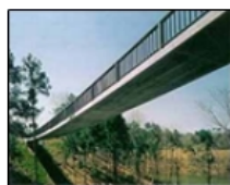
Figura 6 - Tableros de puentes armados con barras PRFV [3]
