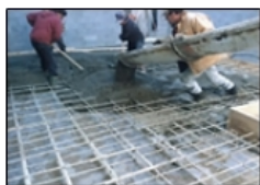
Figura 2 - Hormigonado de pisos con las barras PRFV.
