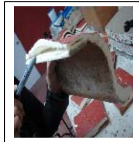
Figura 8. Sustrato de asbesto cemento
