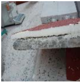
Figura 7. Sustrato de Hormigón
