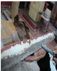
Figura 3. Sustrato de hormigón
