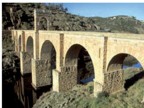
Fig. 1. Puente de Alcántara (Cáceres)
