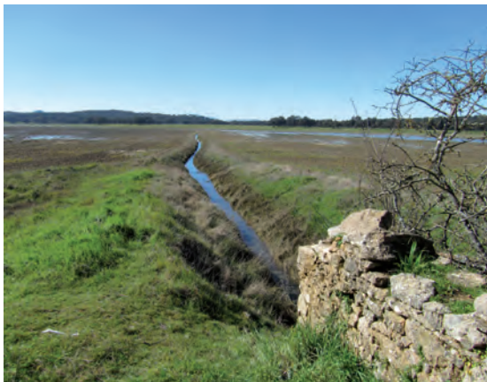
Figura 15. Zanja de drenaje de la Laguna de La Alberca.
