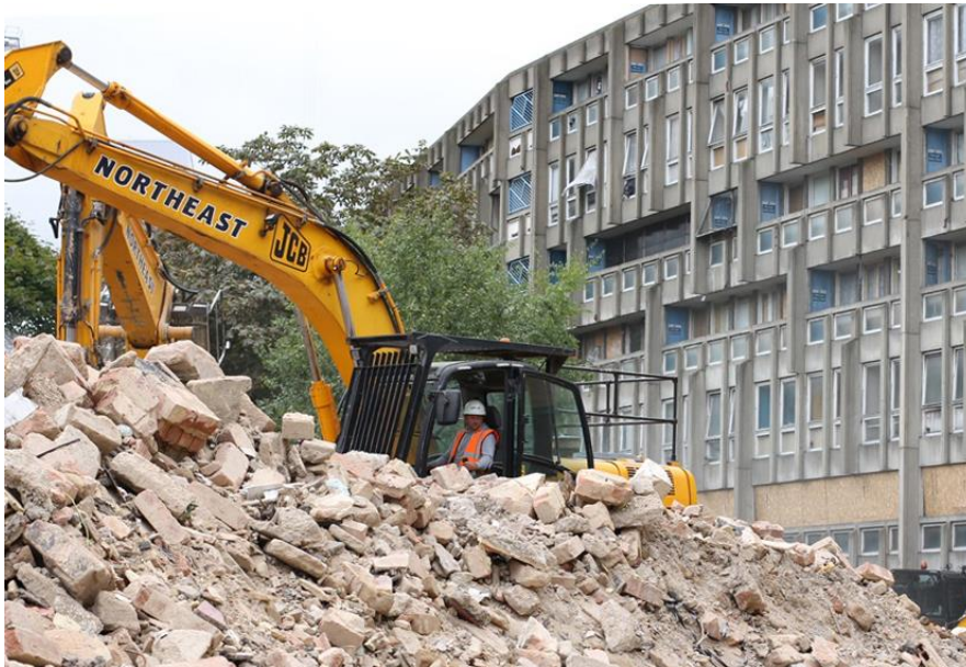
Figura 11.-Demolición del Conjunto de viviendas sociales Robin Hood Gardens , Londres, 7 Septiembre 2017.
