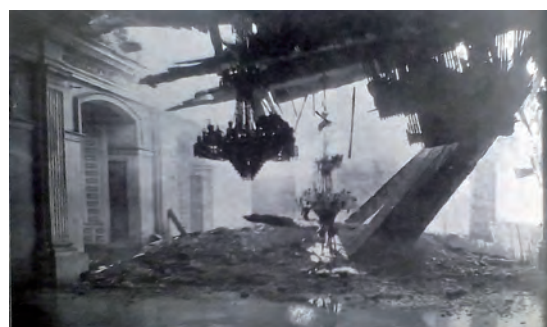
Figura 14. Incendio de la Aduana en 1923; arriba, imagen del segundo piso; abajo, salón de actos con la lámpara a punto de desplomarse.
