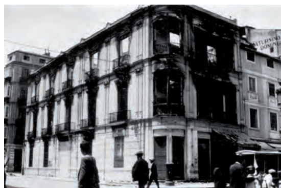
Figura 20. Estado del edificio de La Unión Ilustrada y de La Unión Mercantil después del incendio.
