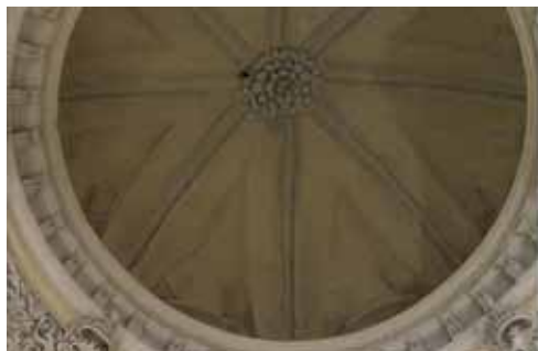
Antes de la intervención.
