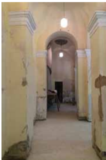
Antes de la intervención.
