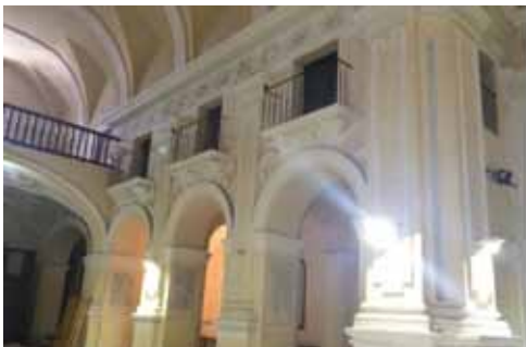
Antes de la intervención.
