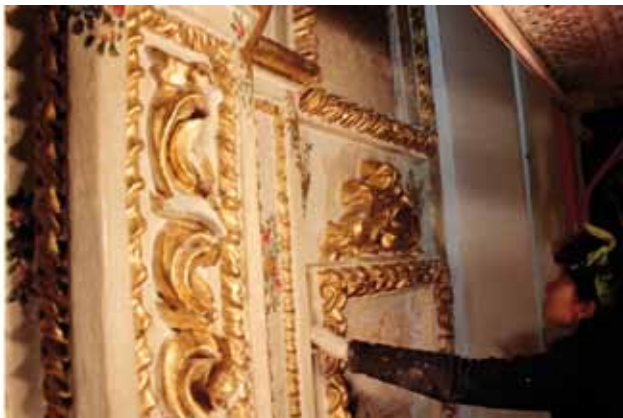
Limpieza y consolidación retablo mayor. Foto P. Pastor.
