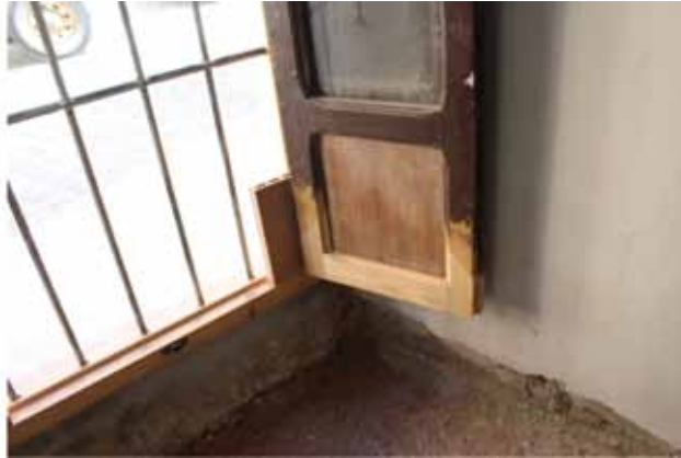
Detalle reparación carpintería. Foto P. Pastor.
