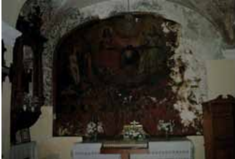
Antes de la intervención.
