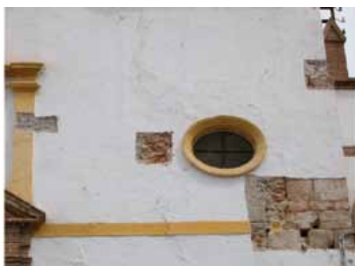
Fisuras debido a la falta de trabazón diferentes materiales. Foto Manuel Nuevo.
