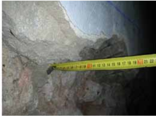
Revestimiento cemento. Muro Sacristía calle Almohalla. Foto P. Pastor.
