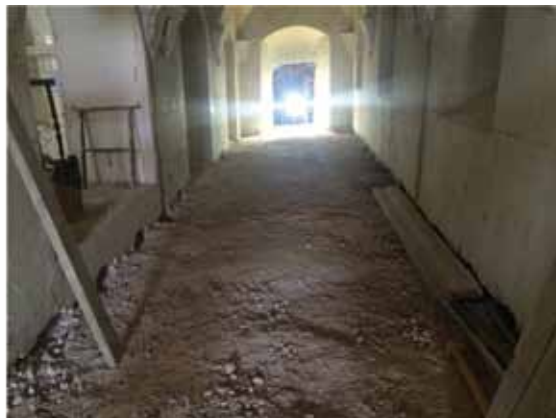
Demolición solera cemento galería. Foto P. Pastor.
