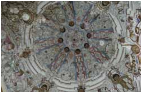
Antes de la intervención.
