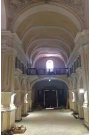
Antes de la intervención.
