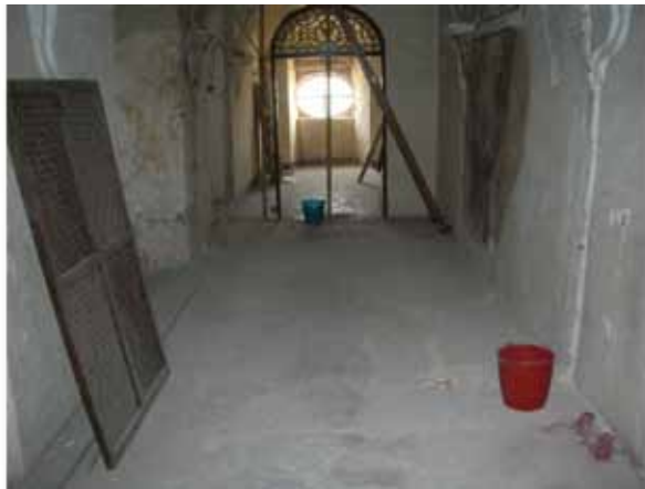
Pavimento de mortero Tribunas. Foto P. Pastor.
