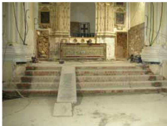
Realización de nuevo peldañado. Foto P. Pastor.
