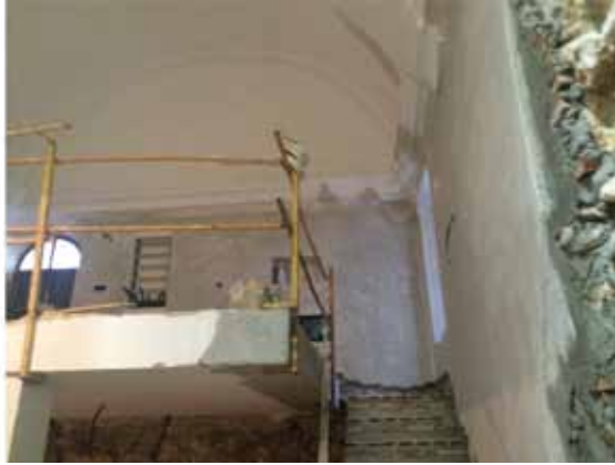
Ejecución nueva escalera de acceso a calle Almohalla. Foto P. Pastor.
