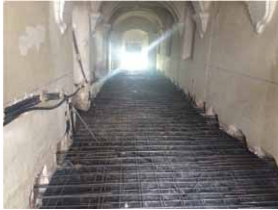
Solera arriostrante en planta alta. Foto P. Pastor.
