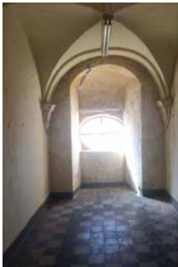
Antes de la intervención.
