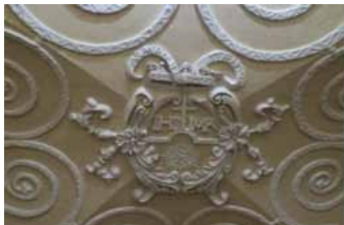
Antes de la intervención.
