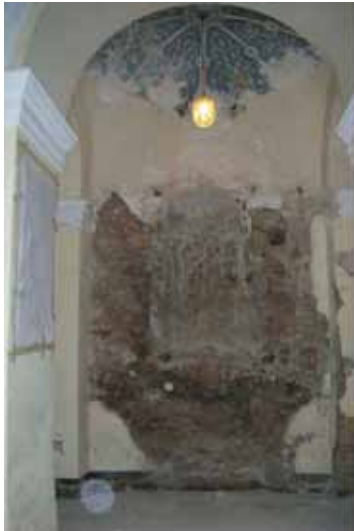
Antes de la intervención.
