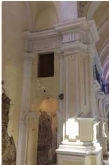
Antes de la intervención.
