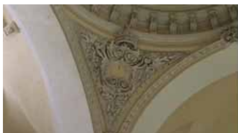
Antes de la intervención.
