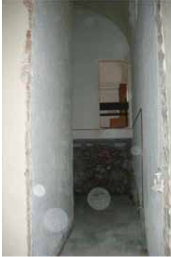
Antes de la intervención.
