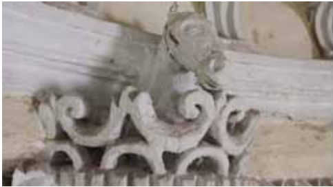
Antes de la intervención.
