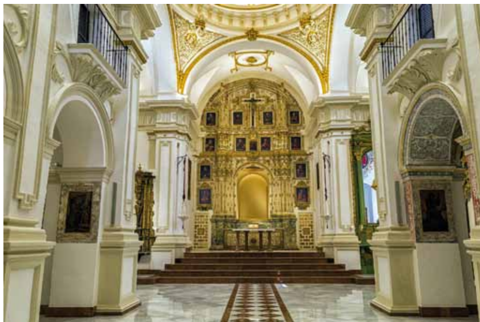
Vista general nueva solería. Foto J. Pastor.
