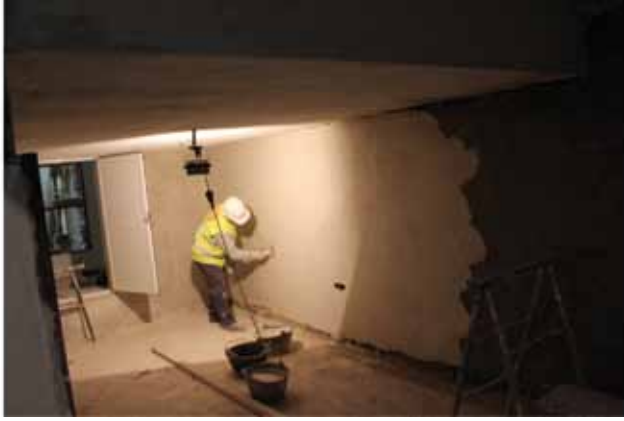
Aplicación de revestimiento con mortero de cal. Foto P. Pastor.
