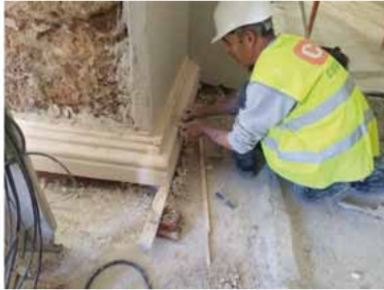
Realización de molduras con terraja. Foto P. Pastor.
