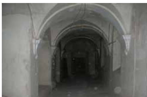
Antes de la intervención.
