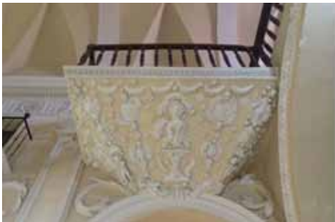
Antes de la intervención.
