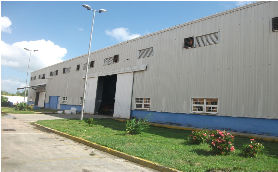
Figura 3.2 Nave Industrial a dos aguas.
