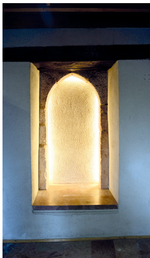
Figura 18. Imagen del paramento interior donde se conserva el arco de la torre antigua.
