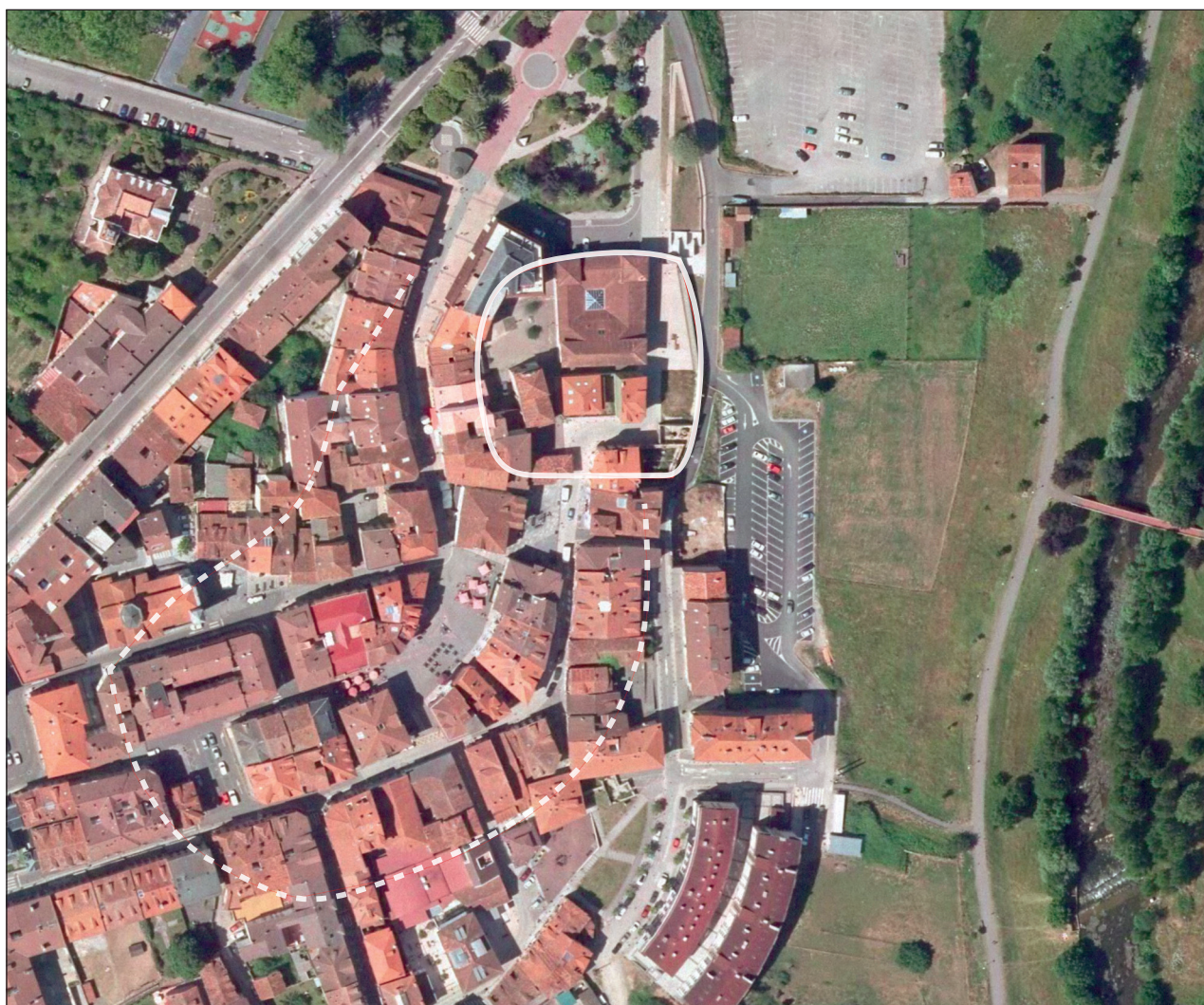
Figura 4. Vista aérea del casco urbano medieval de la villa (tomado del Visor Iberpix 3). Se ha indicado el trazado del recinto amurallado, definido a partir de los datos arqueológicos conocidos y a la planta reflejada en los planos de principios de siglo XX, que se recogen en las Figuras 15 y 16. Con trazo discontinuo se sugiere el espacio ocupado por el área urbana extramuros asociado a los principales viales.
