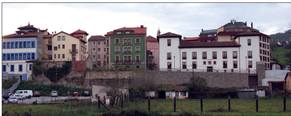
Figura 6. Aspecto del sector oriental de la villa con la muralla restaurada. Se aprecia el desnivel existente respecto a la vega del Cubia.
