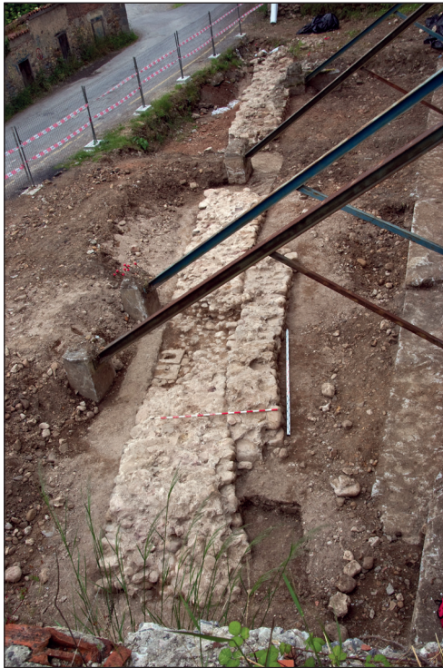
Figura 10. Vista general del trazado excavado de la cimentación de la muralla tomada desde el norte durante el proceso de excavación en el año 2012 (imagen cortesía de Sergio Ríos).
