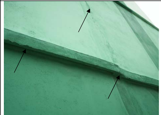
Remates entre elementos prefabricados
