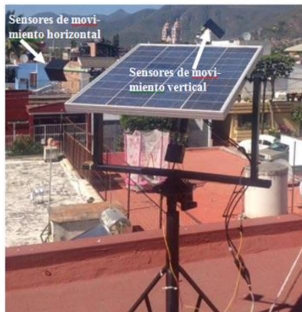
Figura 4. Sensores para el movimiento vertical y horizontal del seguidor solar.
