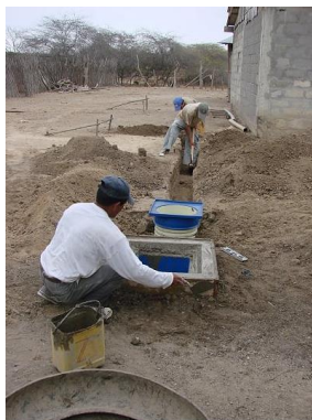
Imagen 3 colocacion de cajas de aceras a lo largo de la via de ingreso
