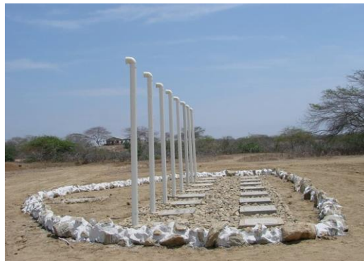
Imagen 11 esquema general del sistema séptico instalado
