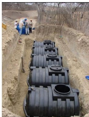
Imagen 5 instalación de serie de tanques, sitio de recolección de aguas residuales
