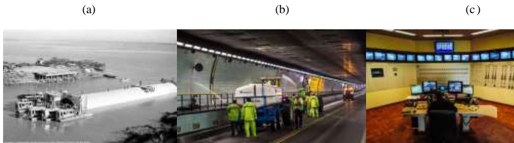
Figura 1. Fotos del complejo túnel sub Fluvial Uranga - Silvestre Begnis. (a) Construcción, (b) interior y (c) sala de control. Fuentes: (a) www.tunelsubfluvial.gov.ar , (b) www.welcomeargentina.com ; (c) www.santafeturismo.gov.ar
