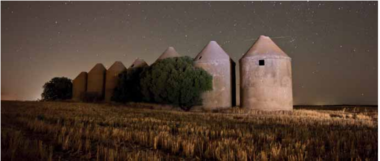
1. SILOS DE HORMIGÓN PREFABRICADOS EN CÁNDÓN (HUELVA).
