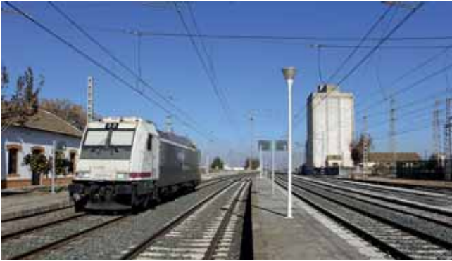
6. SILO DE RECEPCIÓN, TIPO D, EN LA RODA DE ANDALUCÍA.
