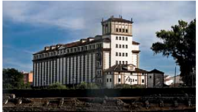
7. SILO DE TRÁNSITO, TIPO T, EN MÉRIDA.
