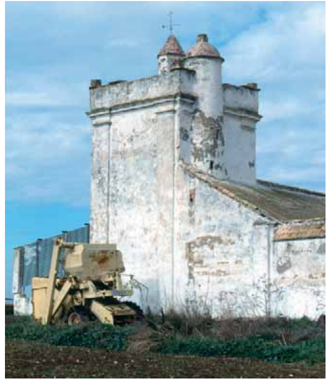
5. TORRE DE ALMAZARA, MOLINO DE LOS FRAILES, LA CAMPANA.
