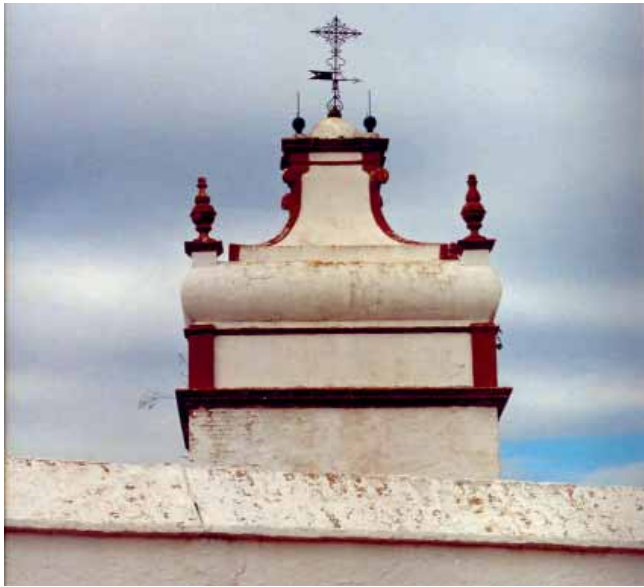
7. TORRE DE ALMAZARA, HACIENDA SAN FRANCISCO, LA CAMPANA.
