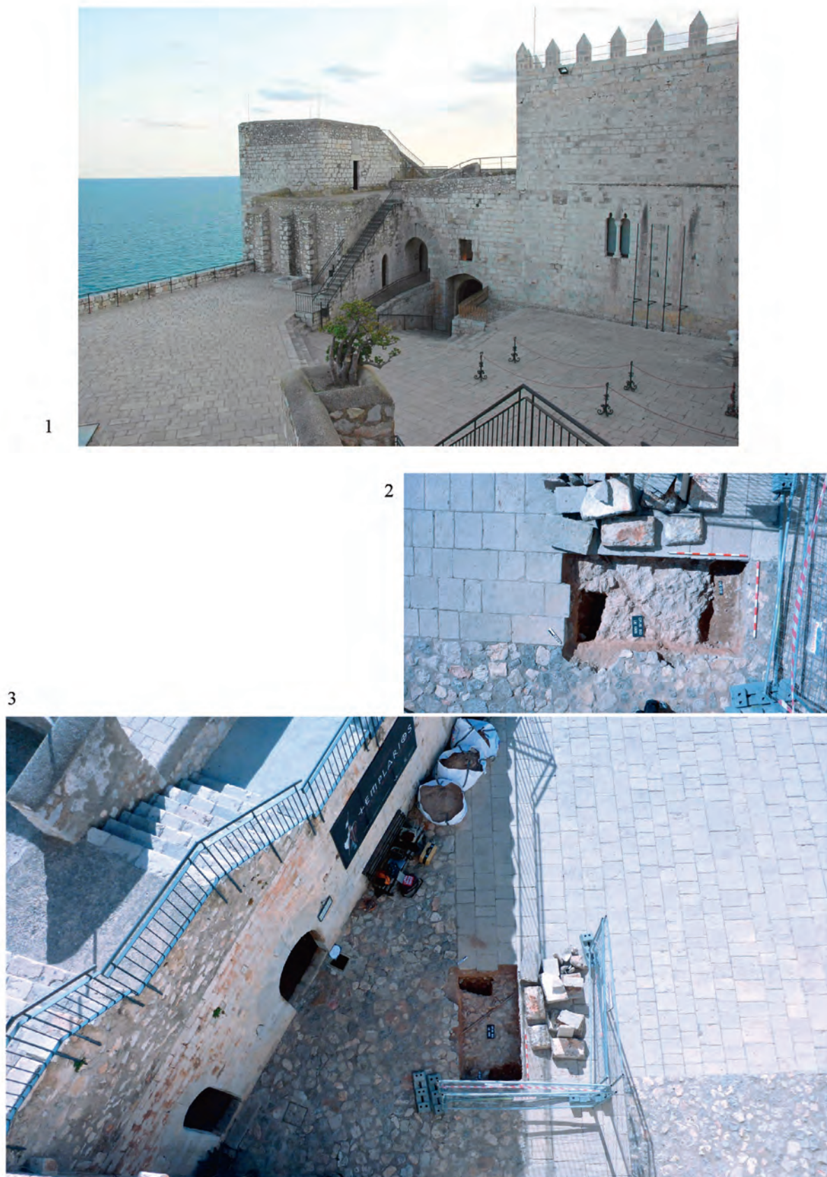
Fig. 16. 1. Vista de la situación de las dependencias del Papa Luna y acceso desde la Planta Baja. 2-3. Cimentación del claustro bajo-medieval.
