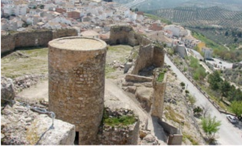
Torre circular, de construcción árabe, y recinto amurallado meridional.
