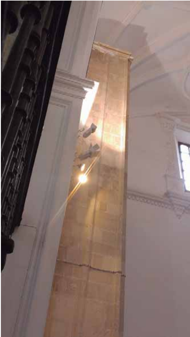
8. FOTO DEL CONTRAFUERTE INTERIOR
