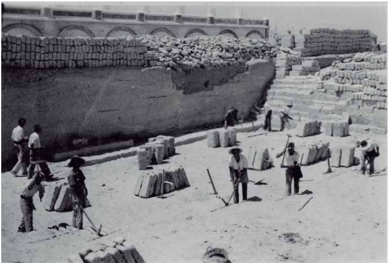
EXTRACCIÓN DE SILLARES EN LA CANTERA DE CRUZ, EN LAS INMEDIACIONES DEL DEPÓSITO DE AGUA, 1957. FOTOTECA DE LA UNIVERSIDAD DE SEVILLA
