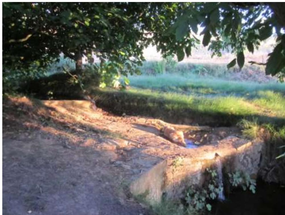
Una represa en el arroyo para captar agua para riego
