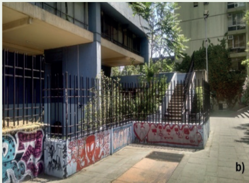
Acceso clausurado a torre: camino interior hacia el Metro Universidad Católica
