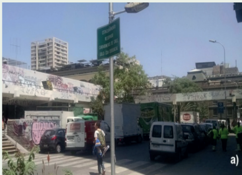
Pasarela sobre la calle Carabineros de Chile
