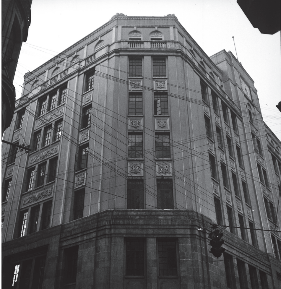
Figura 6. Edificio bancario en el centro de Bogotá
