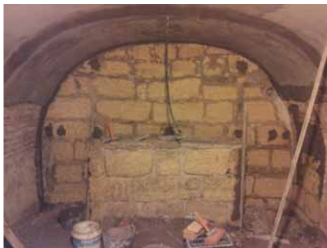
6. MURO OESTE, ALTAR YA CON LOS REVESTIMIENTOS RETIRADOS
