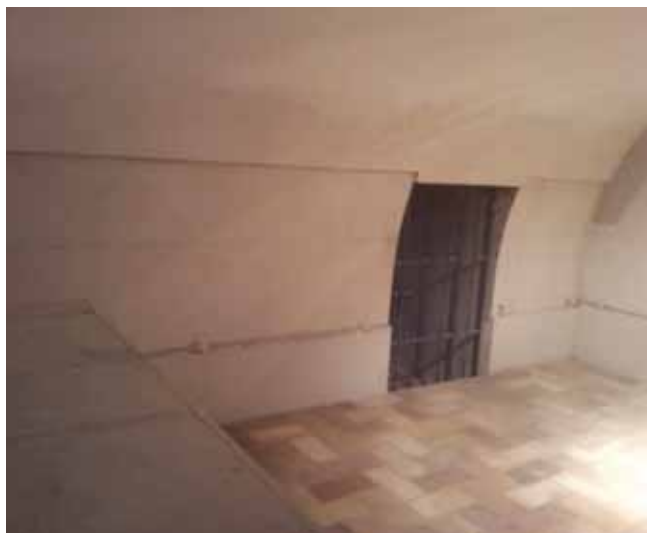
7. MURO DIVISORIO CON GALERÍA DE ENTERRAMIENTOS, A LA ESPERA DE RECOLOCAR LAS PINTURAS
