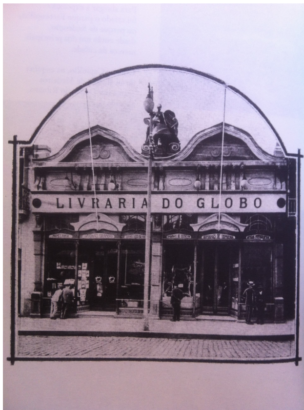
Imagem 1: Livraria do Globo em 1922, na Rua da Praia, em Porto Alegre. Fonte: VERISSIMO, 2011.
