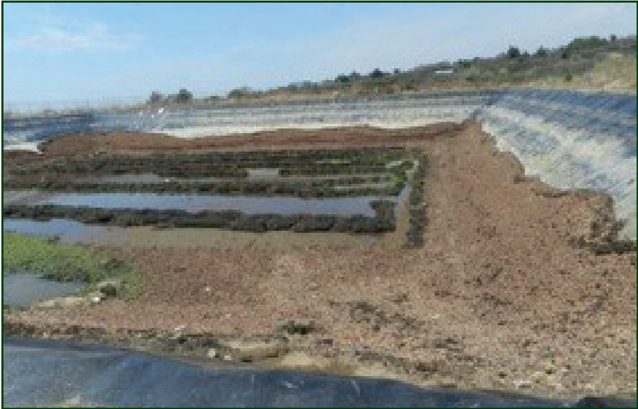
Figura 6. Jagüey de Totolapan con bordes derivadores (Foto de autor)
