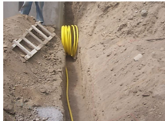
Figura 2. Tubería de polietileno lista a instalarse.
