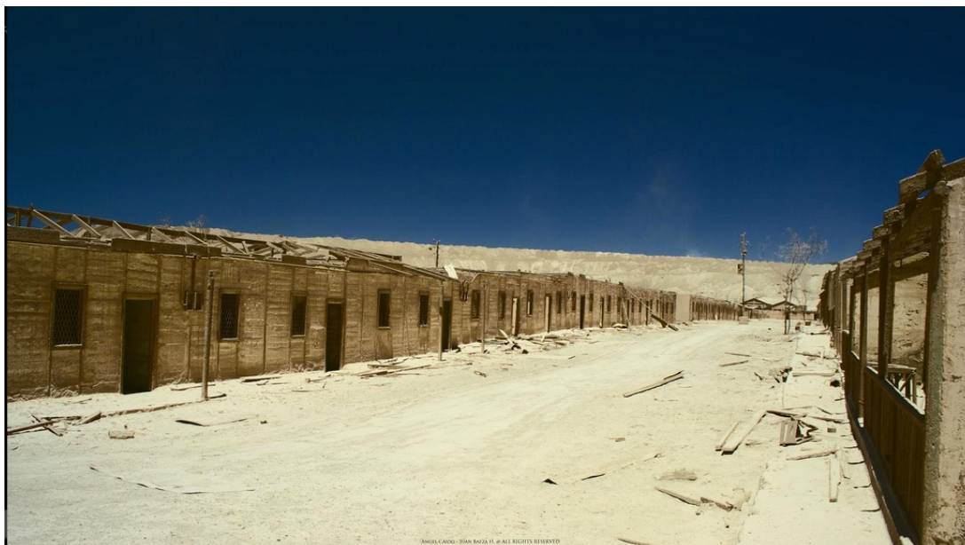
Figura 10. Oficina salitrera Pedro de Valdivia en la actualidad luego de su cierre en 1996. Web. 19 jun. 2017. < https://www.flickr.com/photos/angel_caido/5458134515 >. Gentileza del autor.
