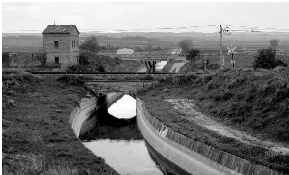
Pont sobre el canal d'Urgell al terme d'Anglesola (Font: Wikipedia).
