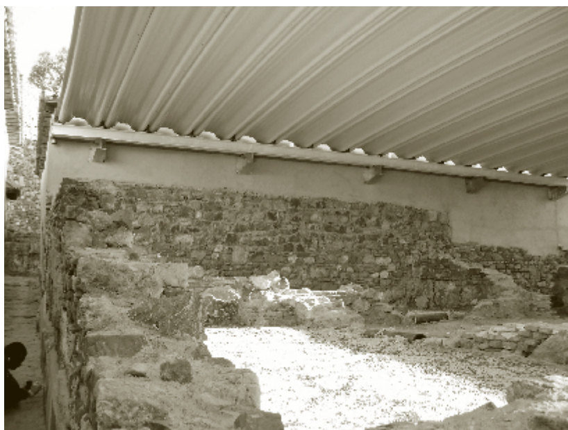
Lámina 7. Detalle de las nuevas cubiertas de chapa instaladas en el Barrio de Casas de la Alcazaba de Málaga en la intervención de 2009
