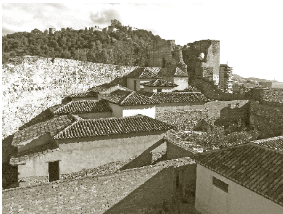
Lámina 6. Aspecto general del Barrio de Casas de la Alcazaba de Málaga, en el que destacan las reconstrucciones del arquitecto Rafael Manzano
